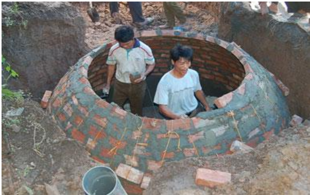
Hình 3.1. Thợ đang xây bể biogas
