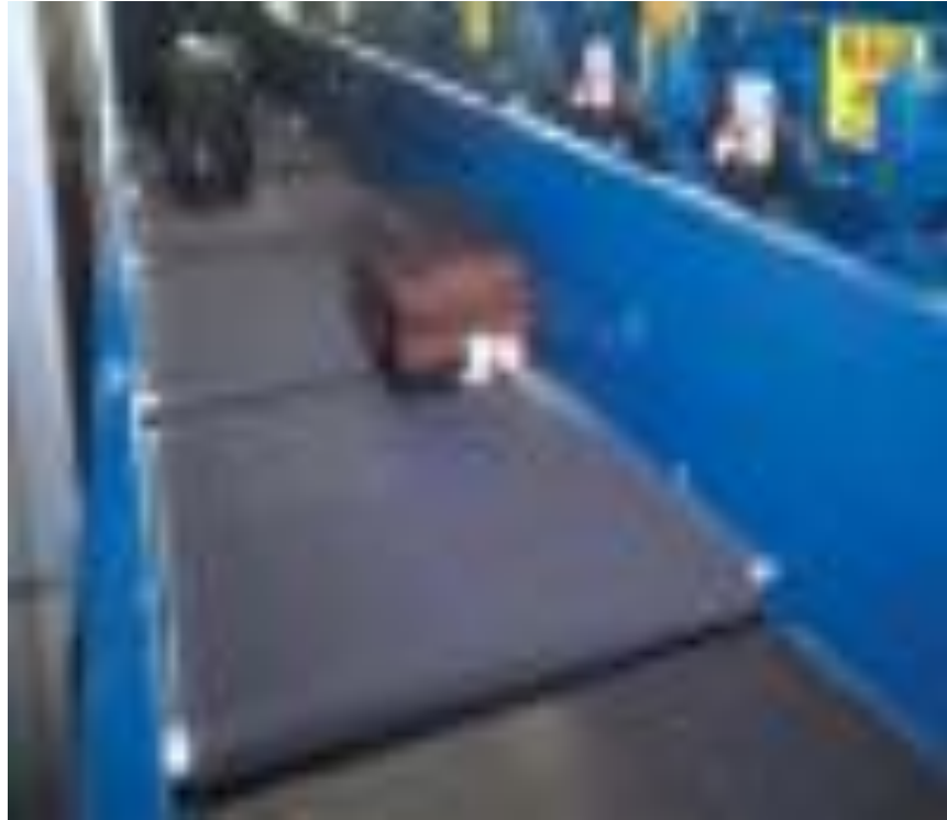
Hình 1.9. Hệ thống băng tải hành lý
