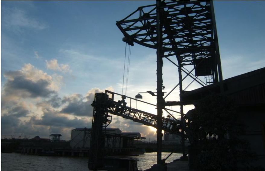
Hình 2.3. Ảnh chụp toàn cảnh hệ thống Ship Loader
