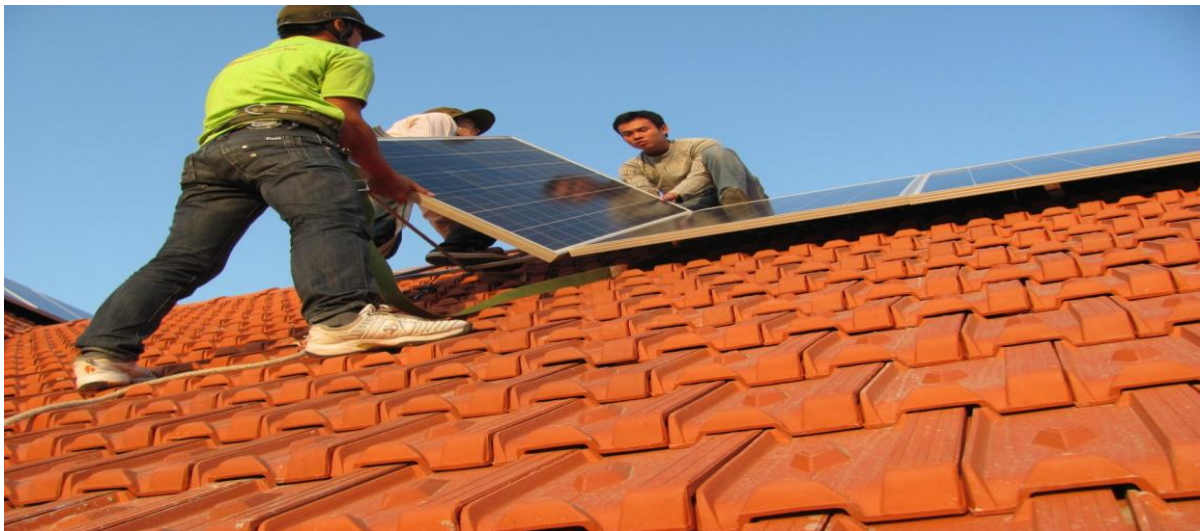
Hình 1.7: Lắp đặt dàn pin số 3
