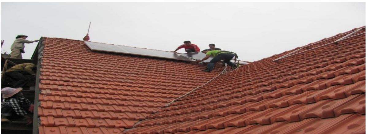
Hình 1.5: Lắp đặt dàn pin số 1
