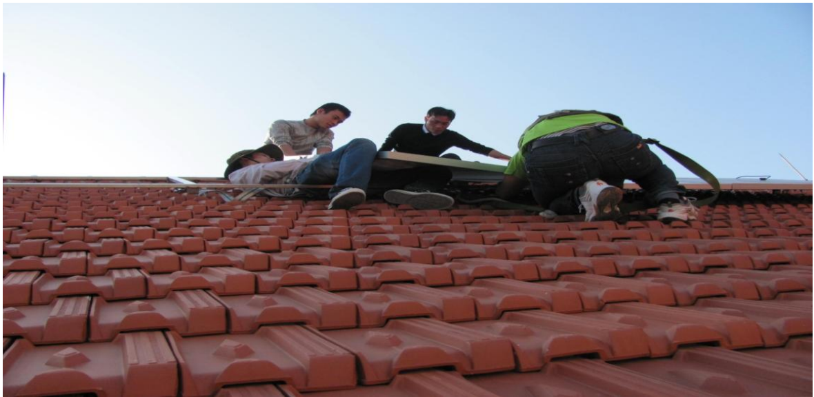
Hình 1.6: Lắp đặt dàn pin số 2
