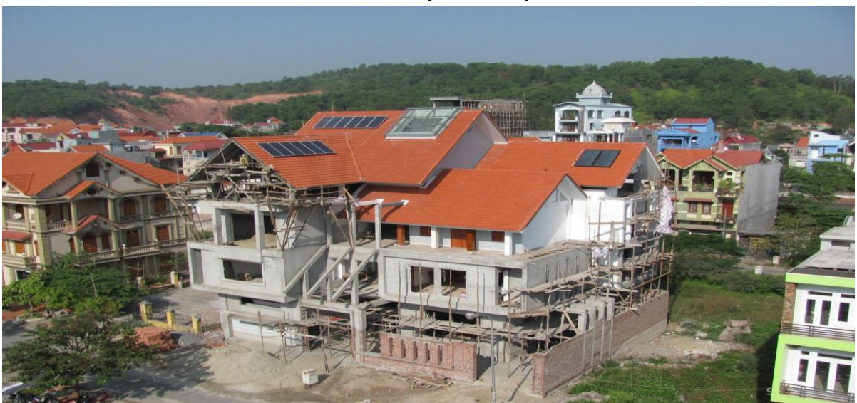
Hình 1.8: Hoàn thành lắp đặt 3 dàn pin mặt trời
