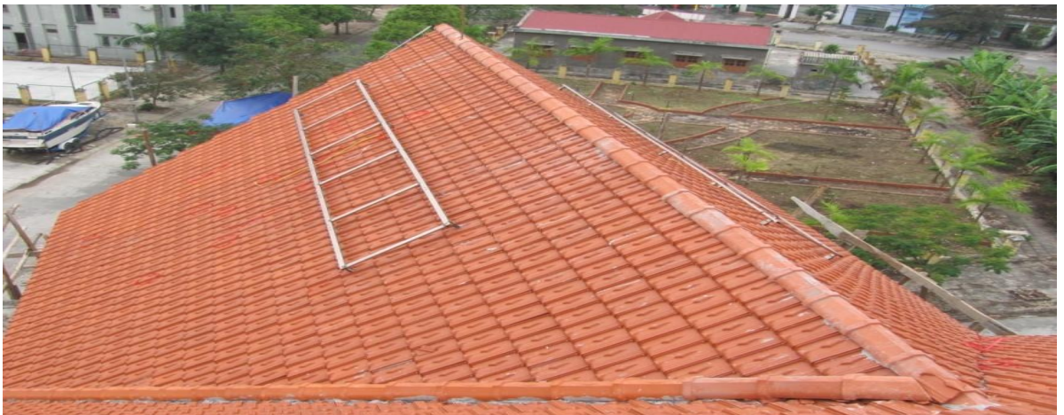
Hình 1.4: Khung dàn tấm pin được hàn cố định trên mái
