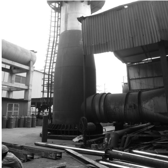
Hình 1.9: Ống khói và bộ hấp thụ nhiệt đưa trở lại vào lò
