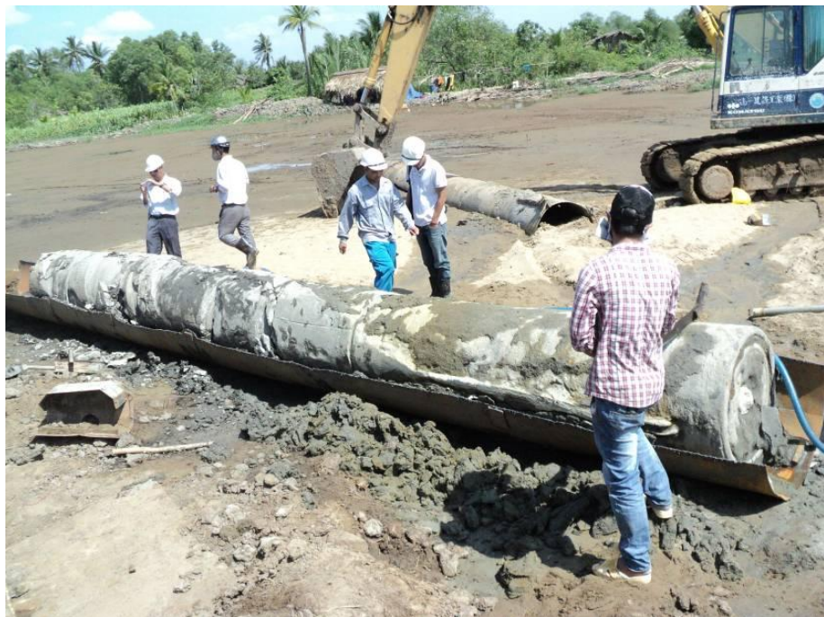
Hình ảnh thí nghiệm nhổ cọc (pull out test)
