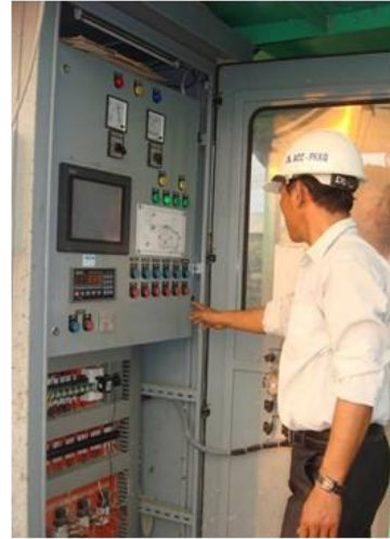
Thợ vận hành trạm trộn đang đặt tự động chế độ cho mẻ trộn
