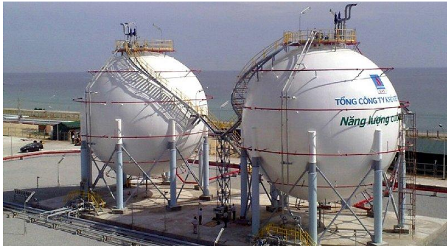
Bể chứa hình cầu Kho chứa LPG Dung Quất
