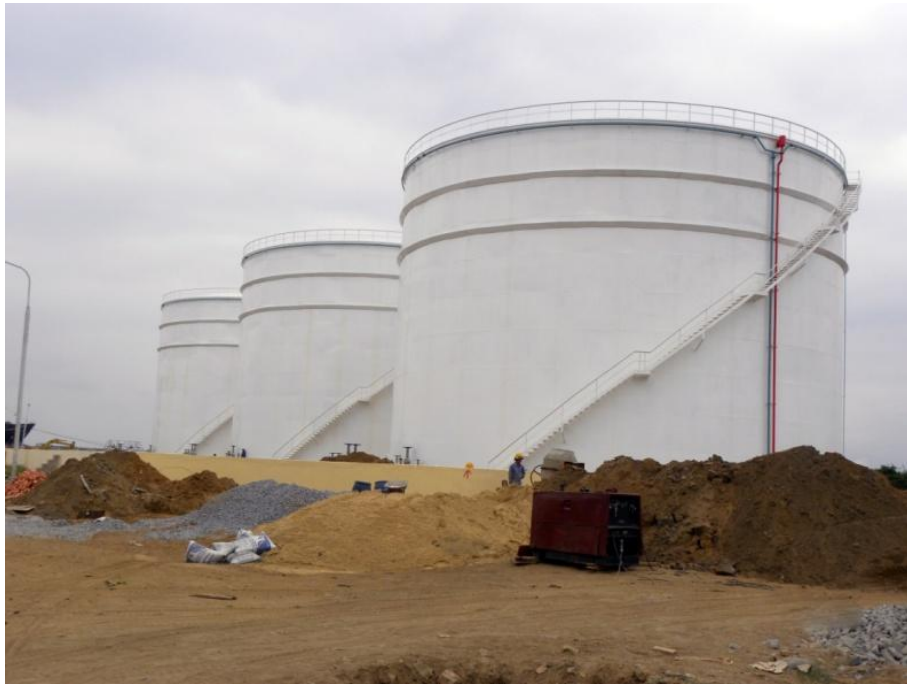
Bể chứa trụ đứng kho xăng dầu Nhà Bè.
