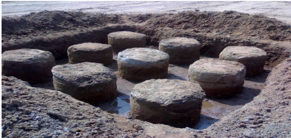
Hình ảnh thí nghiệm đào lộ đầu cọc
