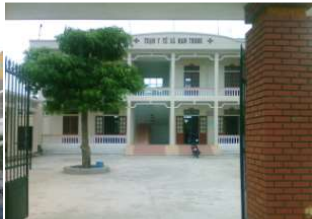
Trạm y tế xã
