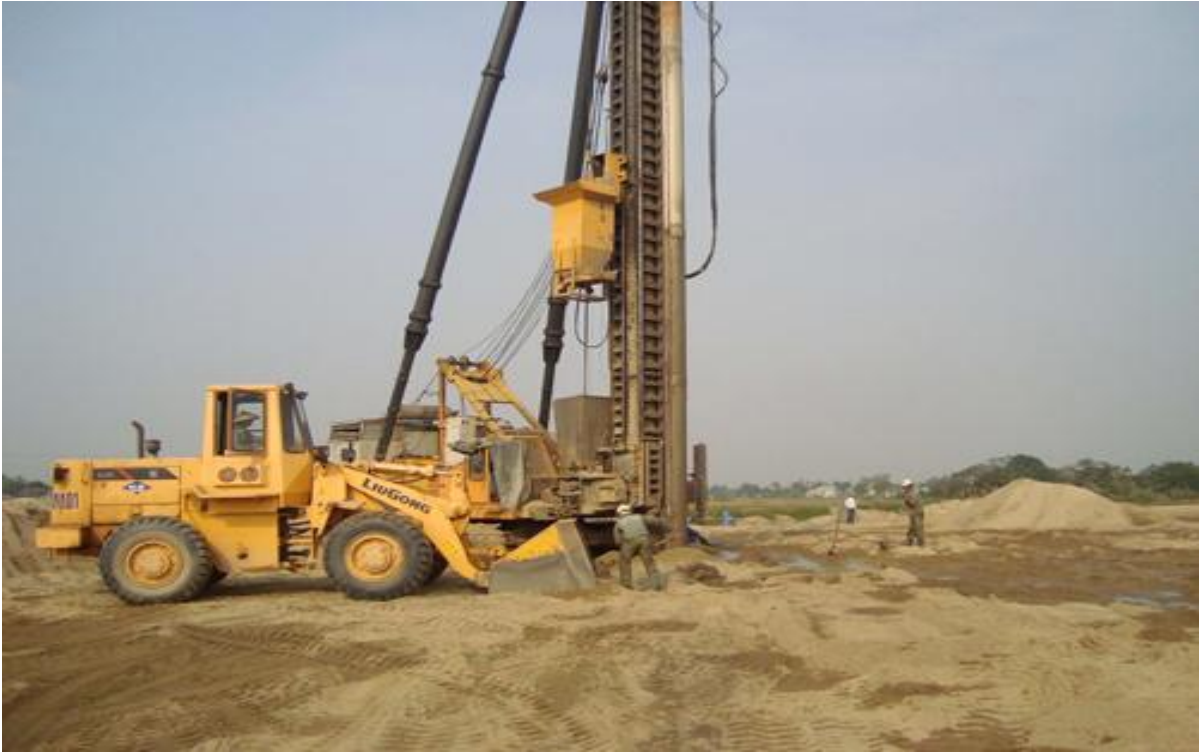
Hình 2.8: Thiết bị đóng cọc cát không dùng ống thép
