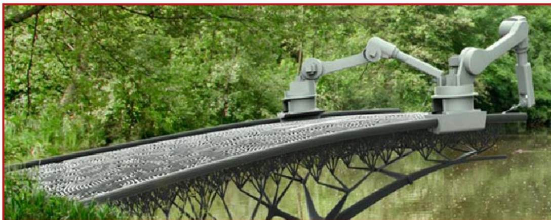
Xây cầu bằng công nghệ in 3D
