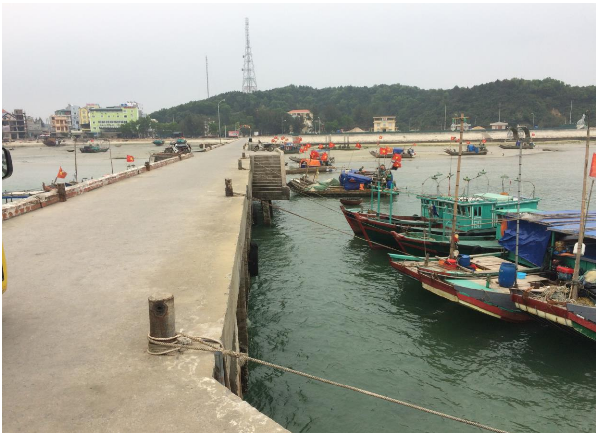
Hình 35. Đệm chống va cho tàu thuyền không có, phải dùng lớp ô tô thay thế
