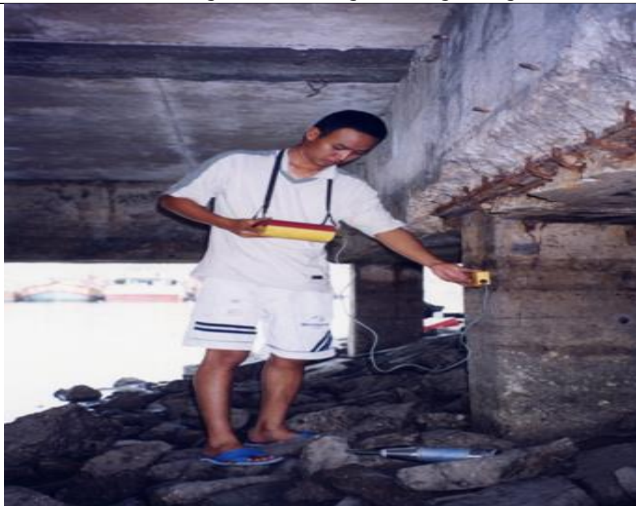
Hình 33. Sử dụng máy đo điện thế để xác định tiết diện cốt thép
