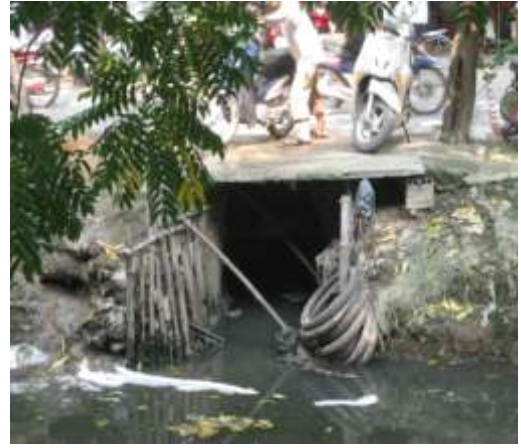
Cống thoát nước thải trực từ KTT ra mương Thành Công
