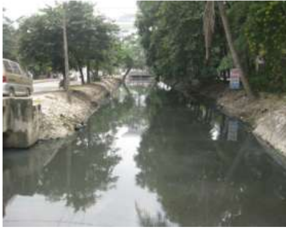
Nước mương Thành Công màu đen và bốc mùi hôi thối
