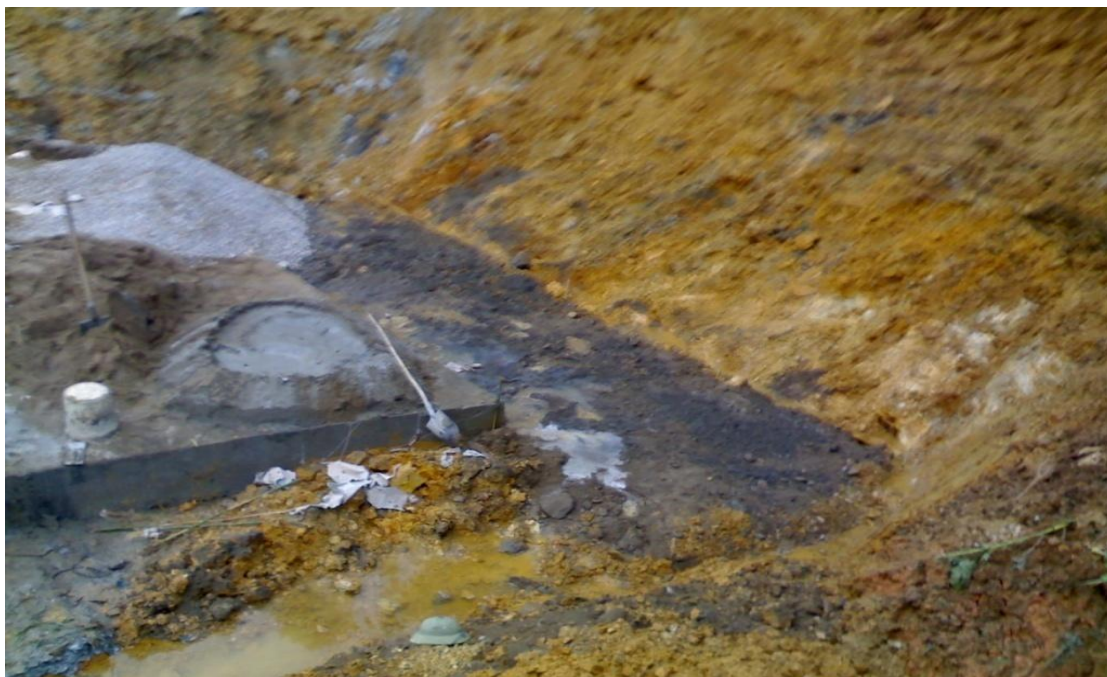
Xử lý trước khi xây đoạn gia cố
