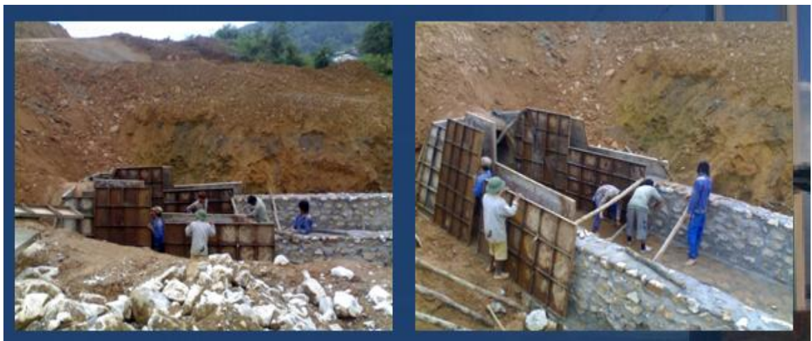
Lắp dựng ván khuôn
