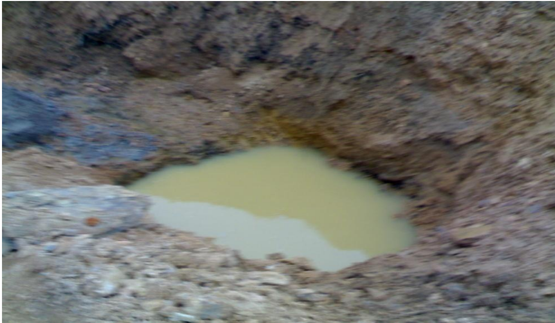
Đào hố thu nước ở phía hạ lưu (khi nào nước đầy sẽ tiến hành bơm hút)
