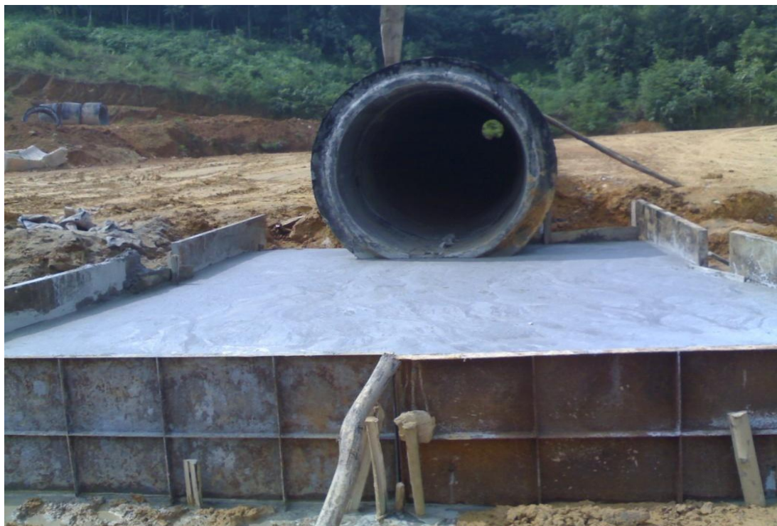
Sân công sau khi hoàn thành
