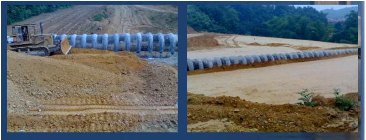
Ủi và lấp đất 2 bên mang cống
