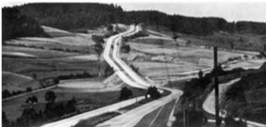
Hình 31a :Tuyến đường sử dụng đoạn thẳng dài và đường cong ngắn làm mất cảnh quan
