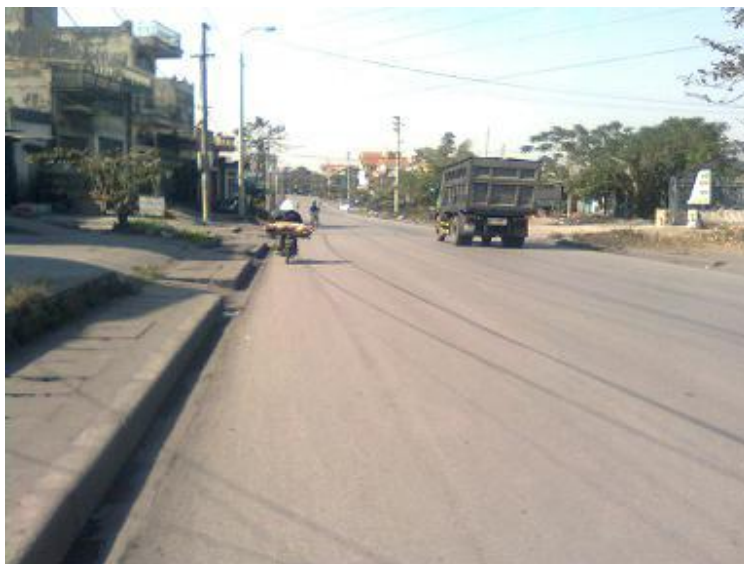
Thoát nước mưa dọc quốc lộ 18A
