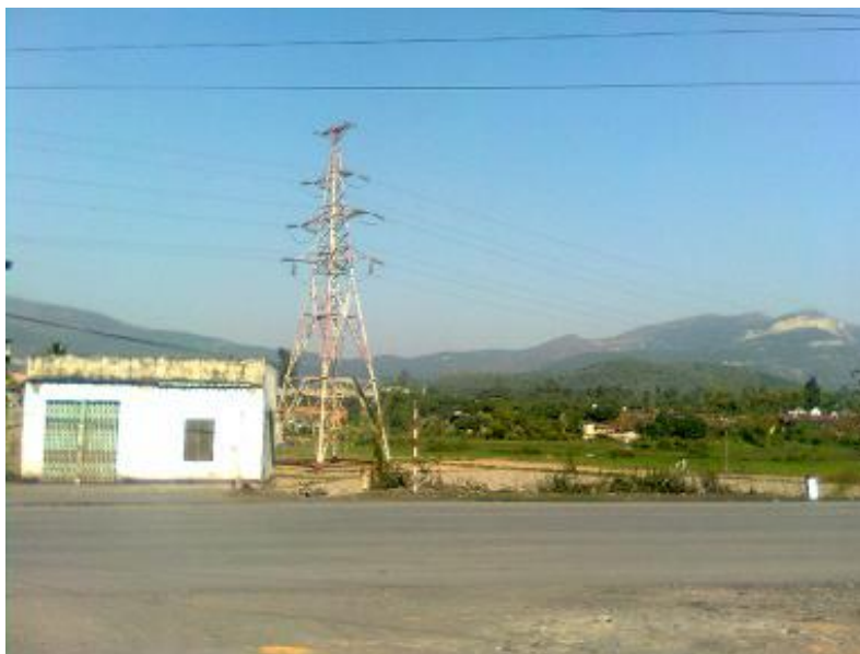
Đường điện 110KV cắt ngang quốc lộ 18A
