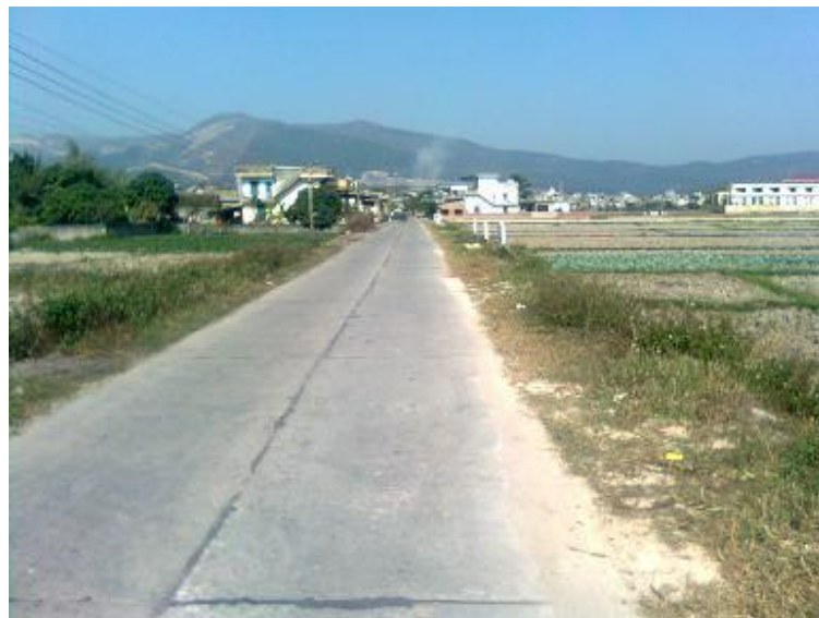
Đường giao thông nội bộ
