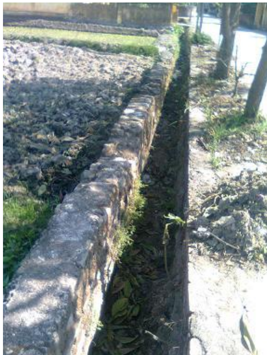
Thoát nước mưa nội bộ
