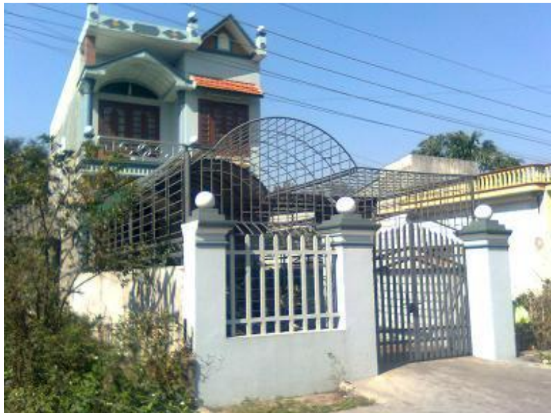
Nhà mặt phố xây dựng kiên cố
