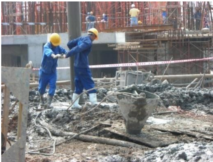
Hình 33 Lắp ống đổ bê tông
