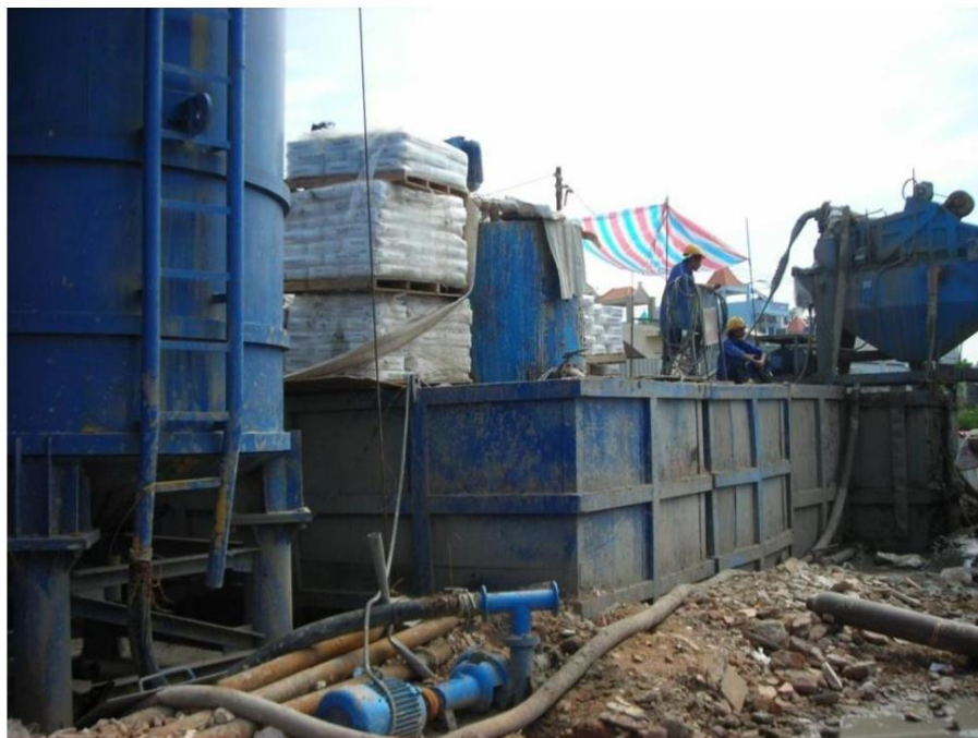
Hình 37 Trạm cung cấp và sử dụng Bentonite
