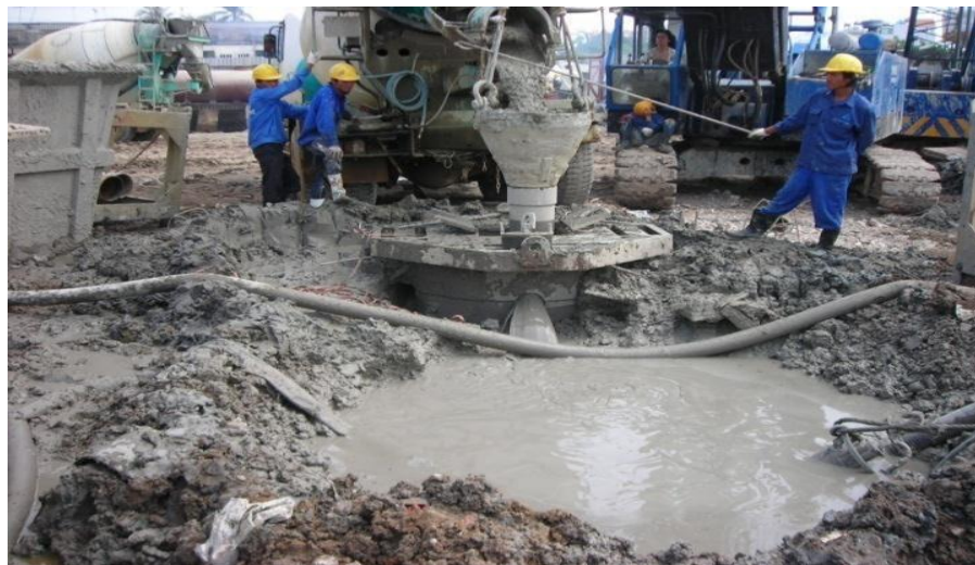
Hình 35 Đổ bê tông và thu Bentonite
