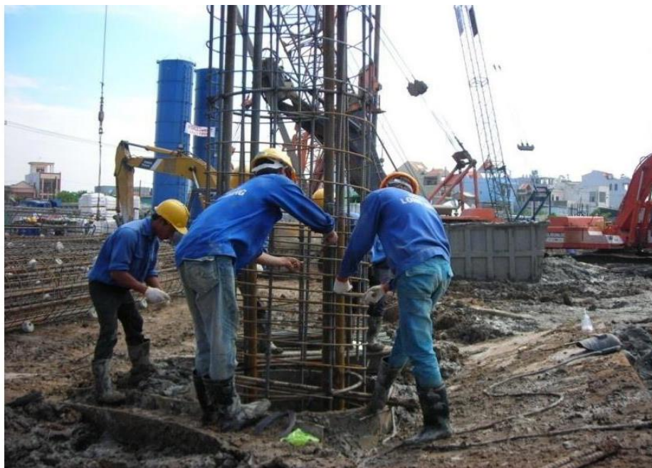
Hình 32 Nối buộc cốt thép
