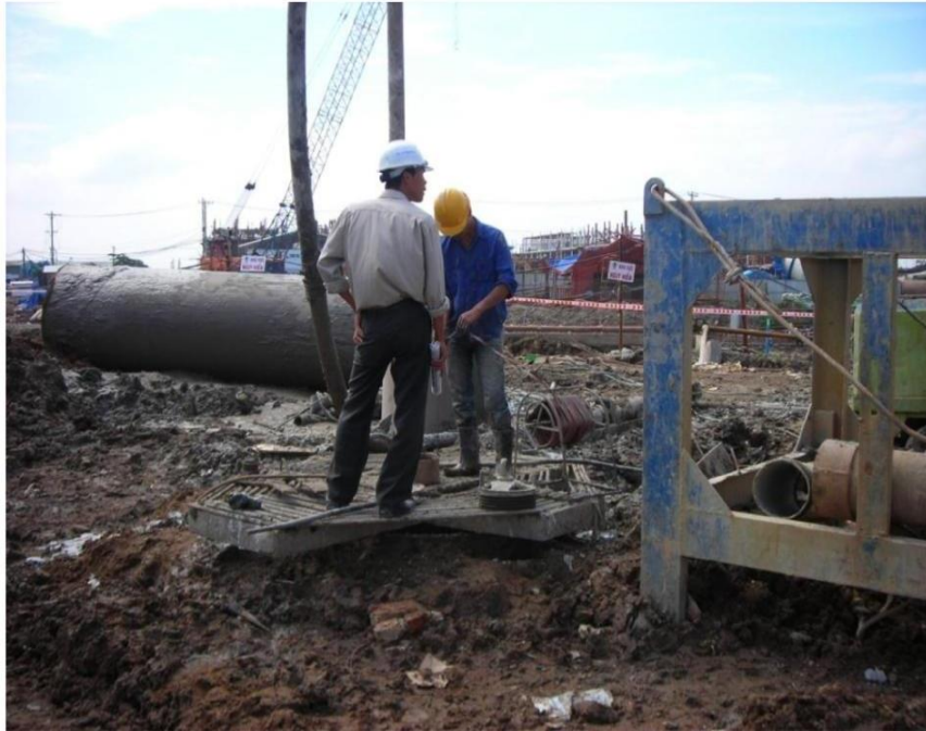
Hình 28 Kiểm tra độ sâu hố khoan
