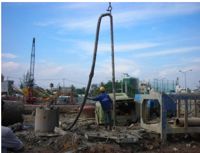
Hình 30 Xử lý cặn lắng
