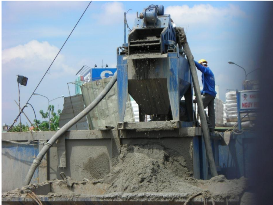
Hình 36 Máy xử lý Bentonite
