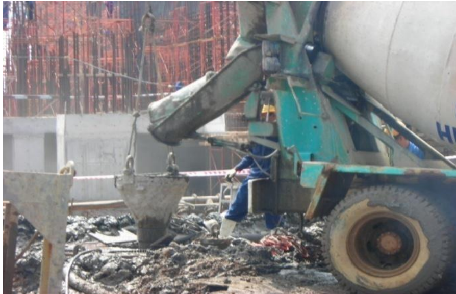
Hình 34 Đổ bê tông cọc
