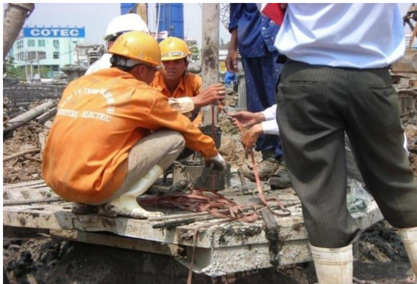
Hình 29 Kiểm tra độ sâu hố khoan
