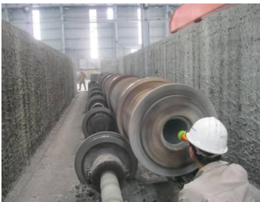
Hình 2.16 Kiểm tra cọc khi quay
