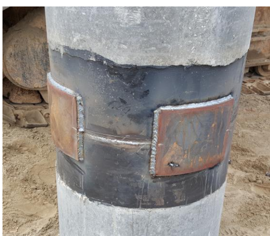
Hình 2.6.2 Hàn nối cọc có bản táp
