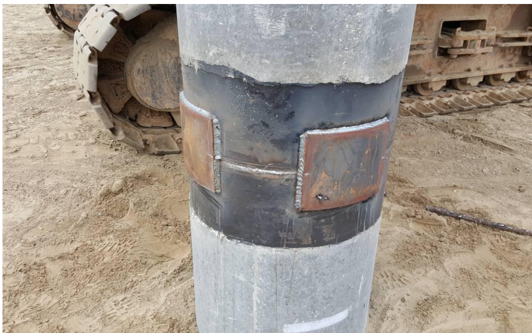
Hình 2.26 Mối nối cọc ly tâm dự ứng lực có bản mã
