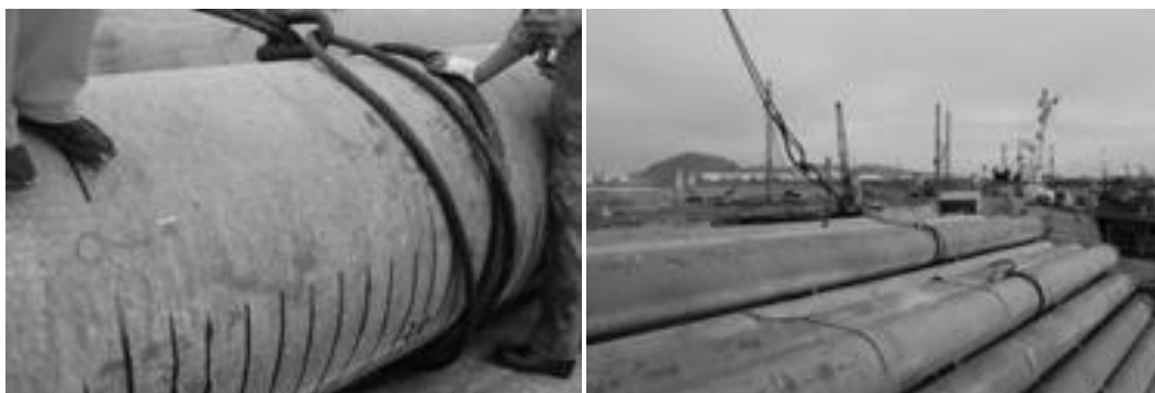
Hình 2.4.5 Vòng cáp cầu cọc ống
