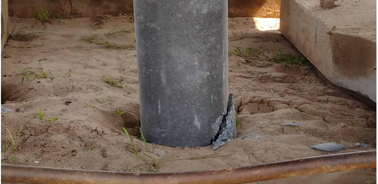
Hình 2.4 . 12 Cọc bị gãy ngang thân khi ép
