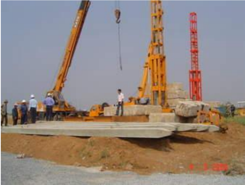
Hình 1.3 Máy ép tĩnh theo phương cổ điển
