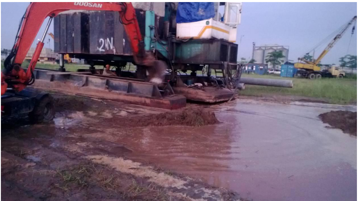
Hình 2.4.2 Máy bị lún do mặt có nước
