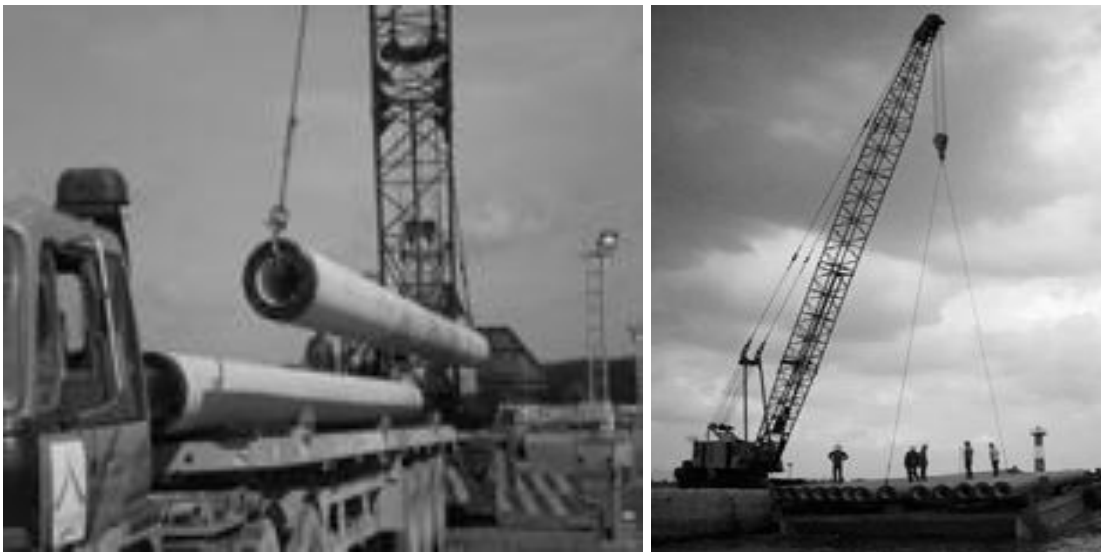
Hình 2.4.4 Cẩu chuyển cọc bằng móc 2 đầu
