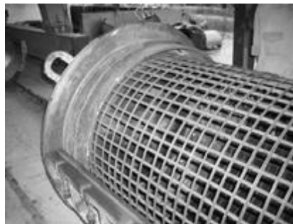
Hình 2.4 . 9 Vòng thép đầu cọc chưa có chi tiết liên kết vào bê tông đầu cọc
