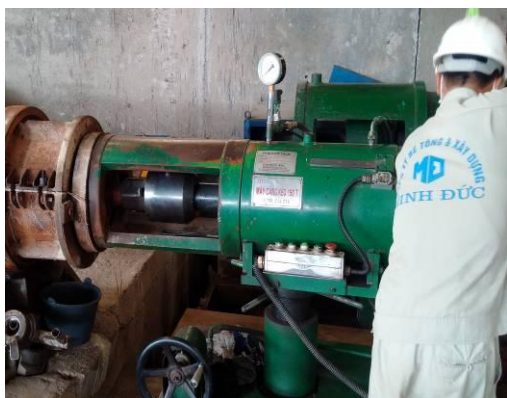
Hình 2.13 Căng dự ứng lực
