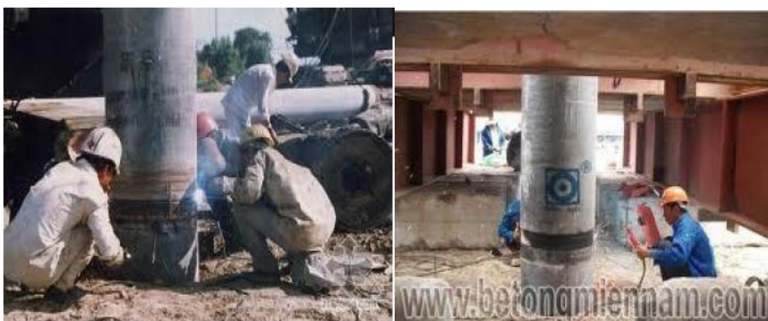
Hình 2.27 Mối nối cọc ly tâm dự ứng lực không dùng bản mã
