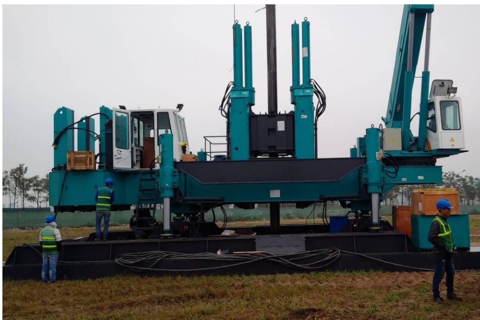
Hình 1.6 Máy Robot ép cọc
