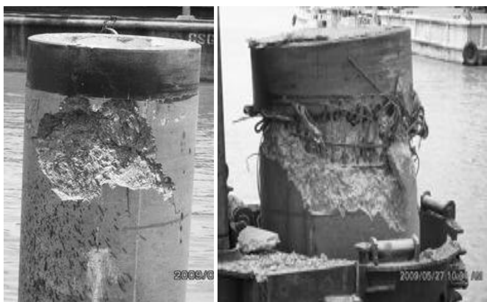
Hình 2.4.8 Cọc bị vỡ đầu sau khi đóng ép
