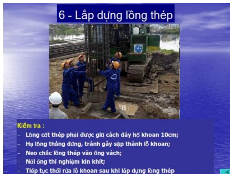
Hình 3.10: Lắp dựng lồng thép
