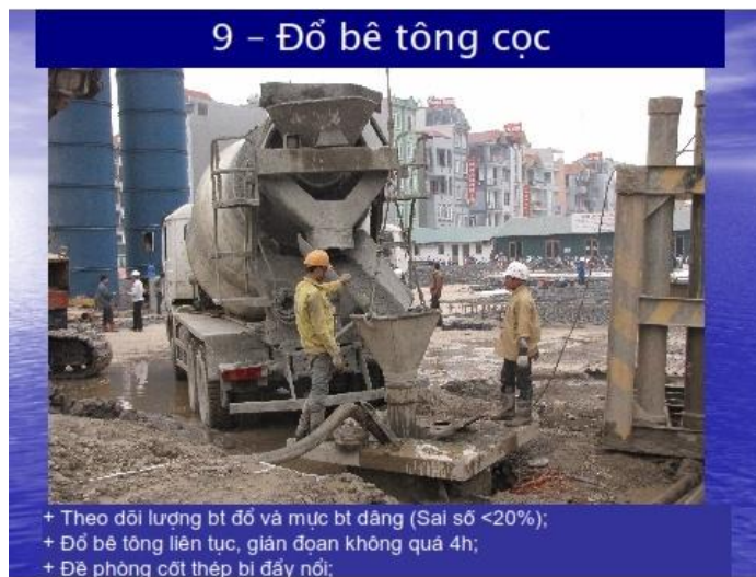
Hình 3.14: Đổ bê tông
