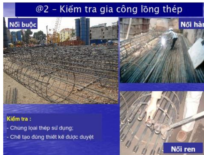
Hình 3.9: Kiểm tra gia công lồng thép
