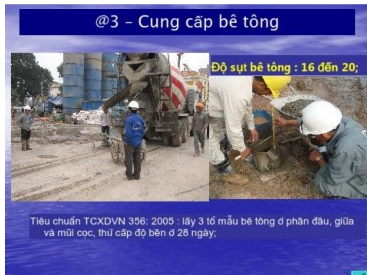
Hình 3.13: Cung cấp bê tông
