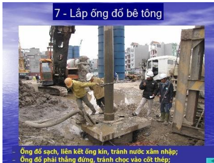
Hình 3.12: Lắp ống đổ bê tông
