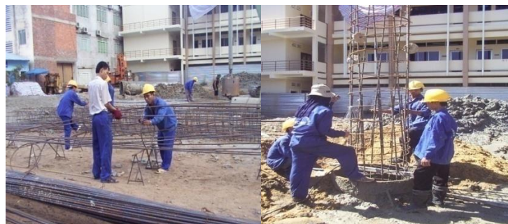
Hình 2.6: Gia công lắp dựng cốt thép cọc
