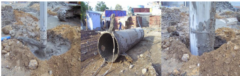
Hình 2.3: Khoan tạo lỗ, bơm dung dịch Bentonite giữ thành
