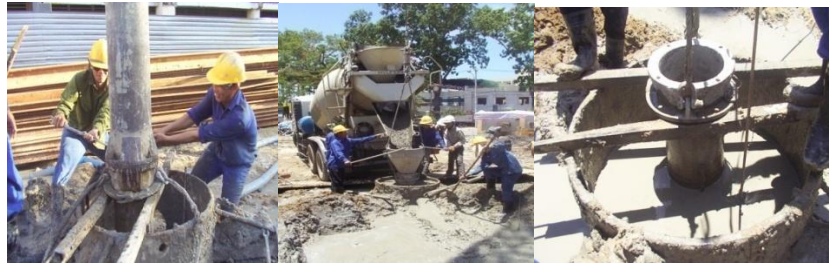
Hình 2.8: Lắp ống đổ Bê tông, đổ bê tông trong dung dịch Bentonite và đo mặt dâng bê tông
