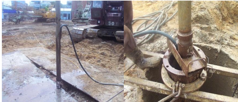
Hình 2.7: Ống Tremie, ống thổi rửa và lắp ống thổi rửa hố khoan
