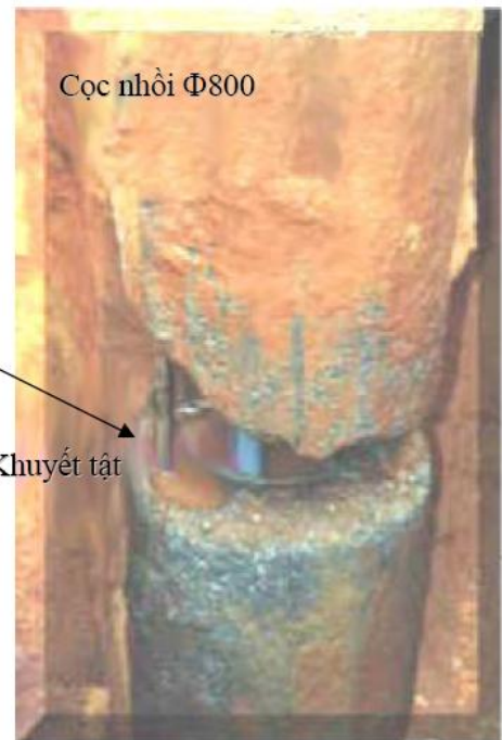
Hình 3. Phương pháp siêu âm phát hiện thân cọc có khuyết tật.
