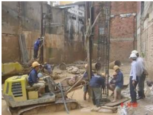
Hình 2.4. Kiểm tra độ sâu hố khoan
