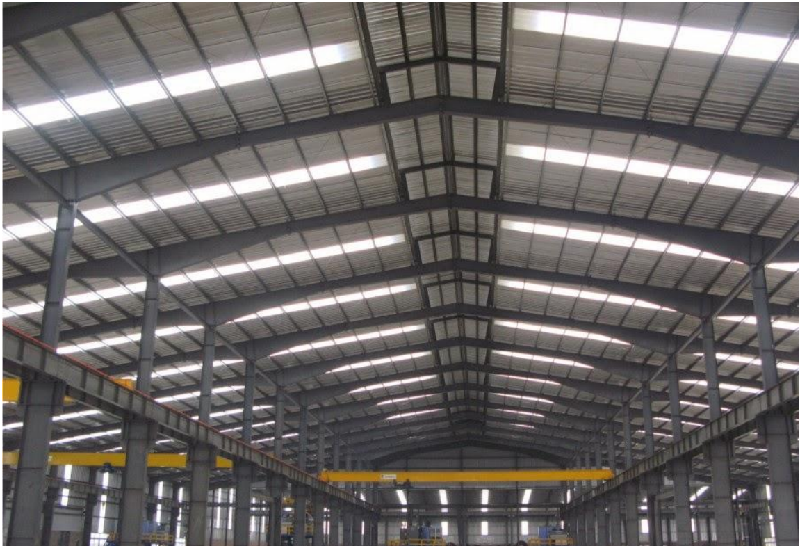
Hình 1-14. Nhà công nghiệp
