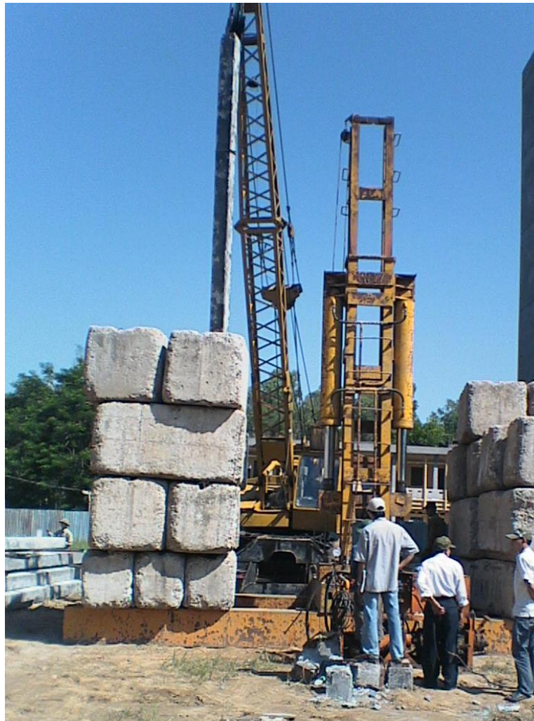
Hình 4-13. MỘT SỐ HÌNH ẢNH ÉP CỌC
