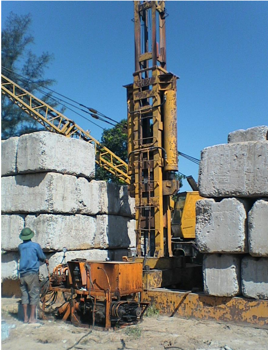
Hình 4-14. THEO DÕI LỰC ÉP TRONG QUÁ TRÌNH ÉP CỌC
