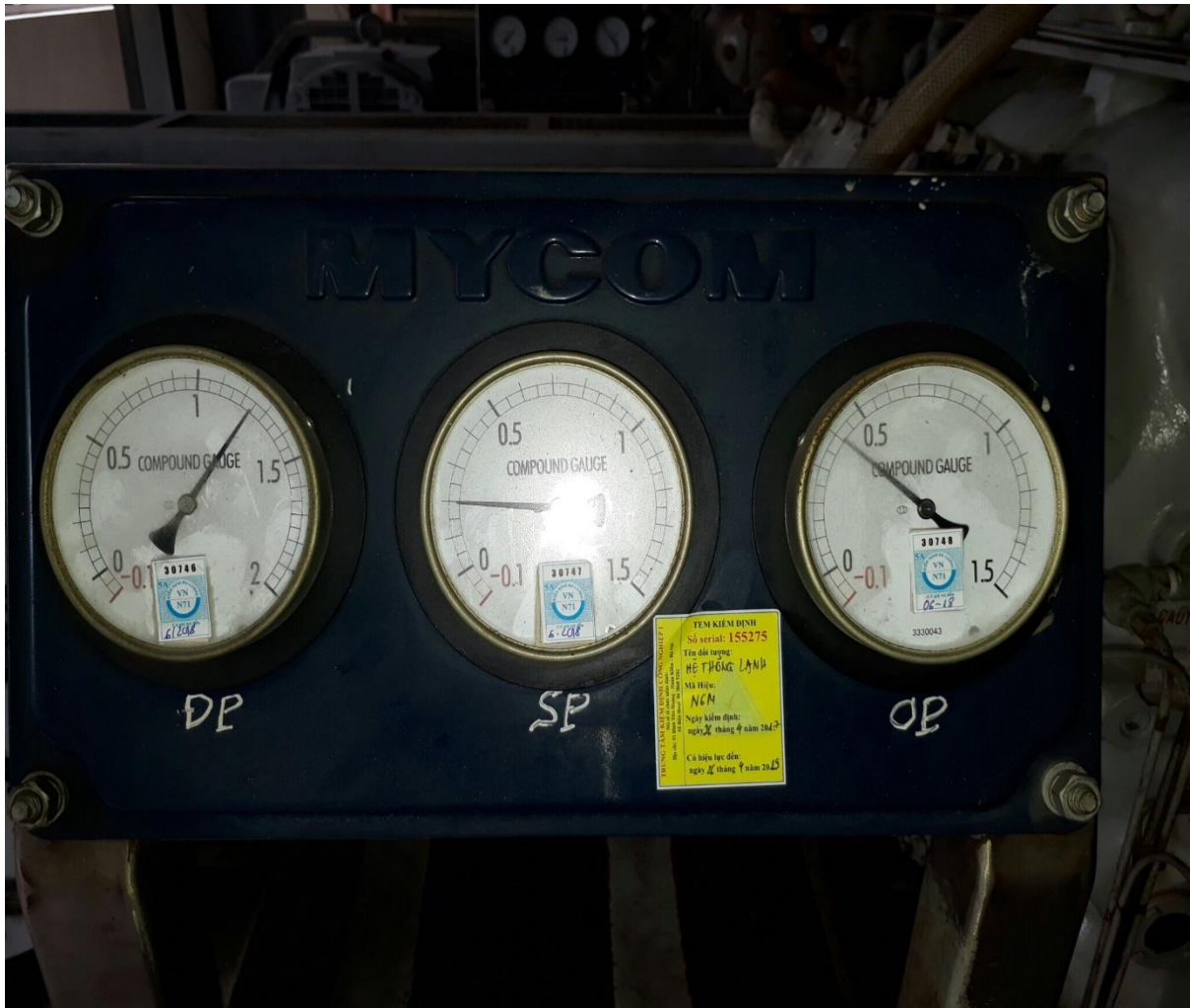
Hình 3.3.3. Đồng hồ đo áp suất( cửa đẩy, cửa hút, dầu )máy nén
