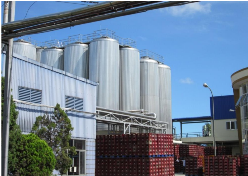
Hình 1.8. Hệ thống tank lên men
