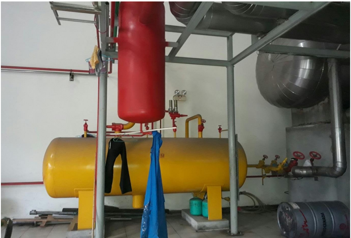
Hình 3.3.2. Hình ảnh bình lỏng cao áp của máy nén
