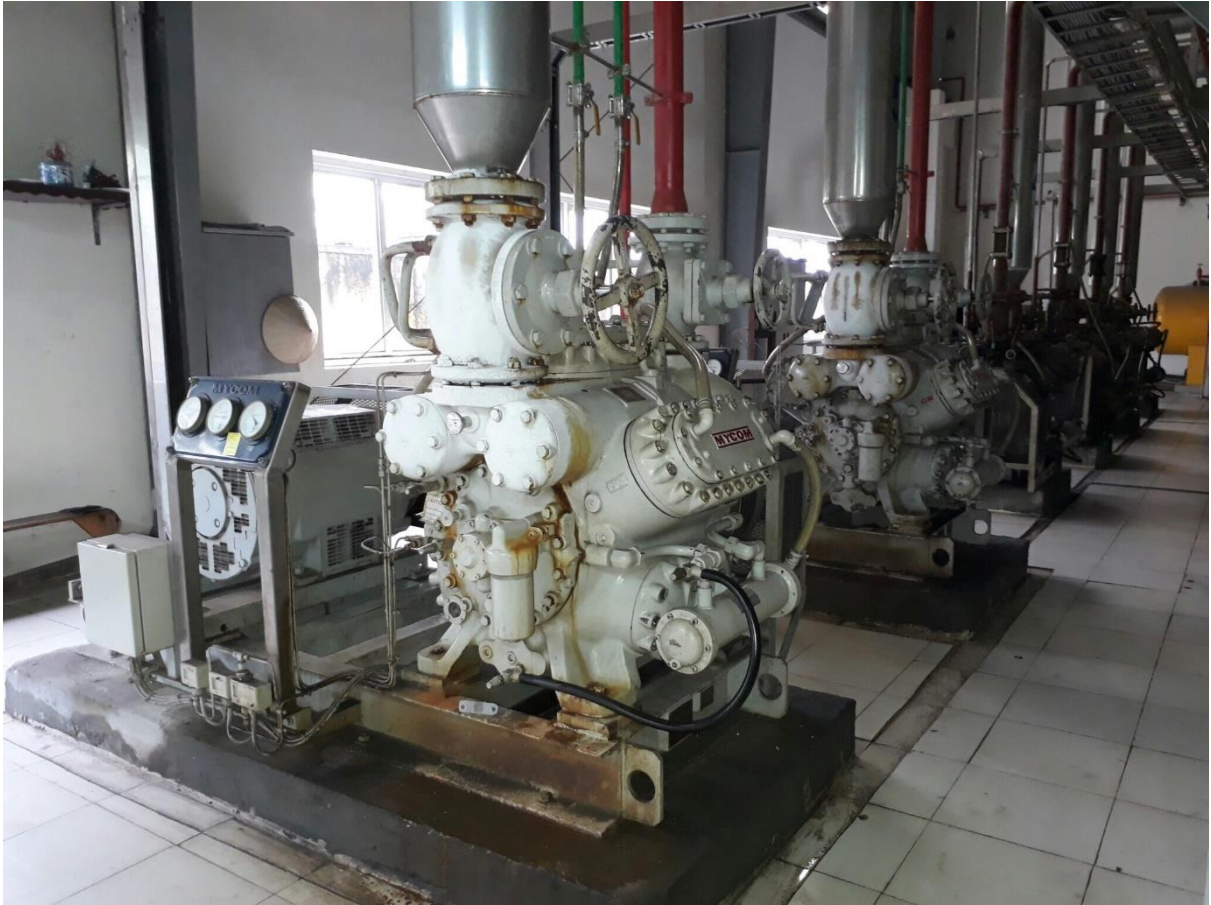
Hình 3.3.1. Hình ảnh máy nén lạnh
