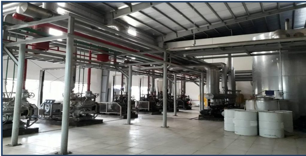
Hình 1.5. Hệ thống lạnh NH 3 .
