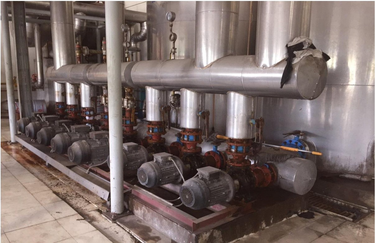
Hình 3.7.2. Hình ảnh bơm tuần hoàn và bơm cấp Glycol
