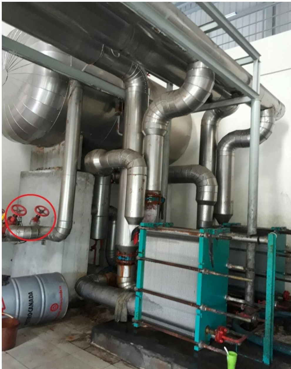
Hình 3.5.1. Hình ảnh van tiết lưu
