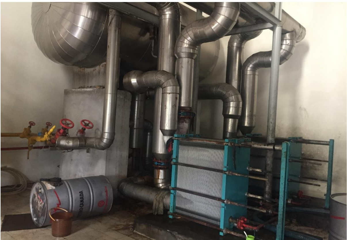
Hình 3.7.3. Hình ảnh hệ thống trao đổi nhiệt của Glycol
