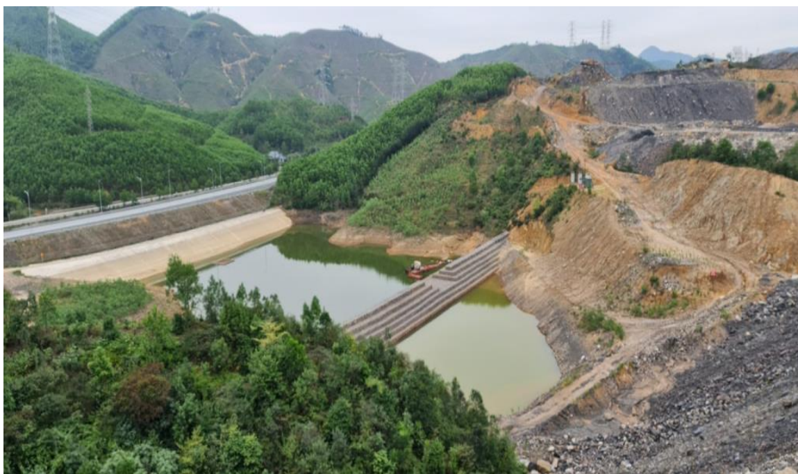
Hình 3.3. Đập chắn chân bãi thải bảo vệ đường Cao tốc Hạ Long - Vân Đồn.
