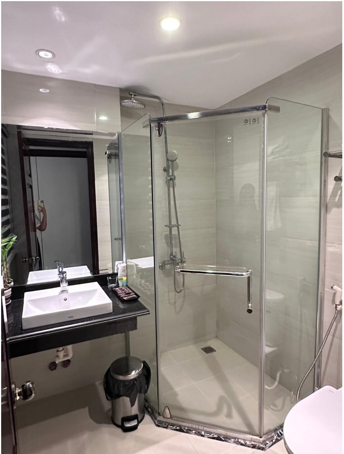
NHÀ TẮM TIÊU CHUẨN
