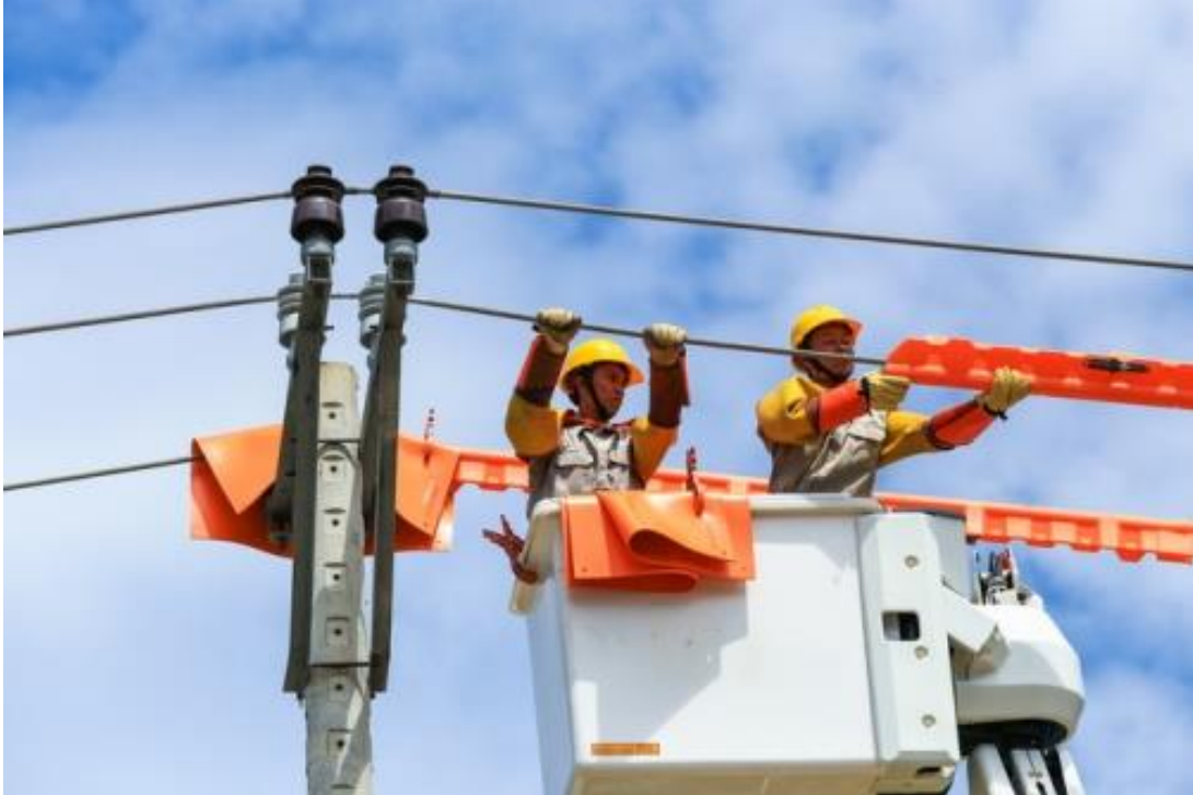
Tăng cường công tác sửa chữa, bảo dưỡng lưới điện bằng công nghệ hotline, nâng cao độ tin cậy cung cấp điện phục vụ khách hàng.
