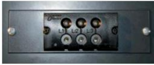
Hình 3.21. Thiết bị chỉ báo có áp.
