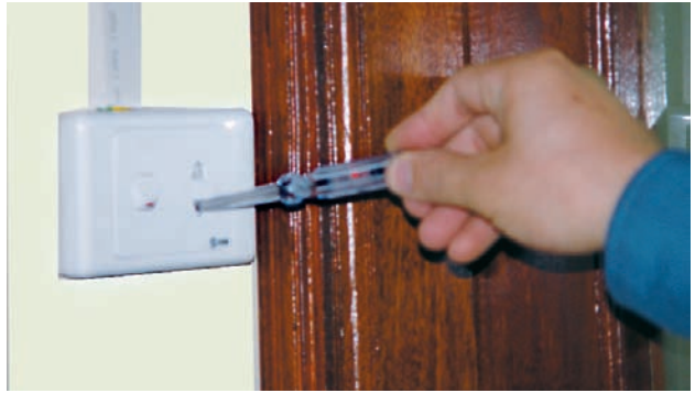
Hình 34.2. Sử dụng bút thử điện để xác định dây pha của mạch điện
