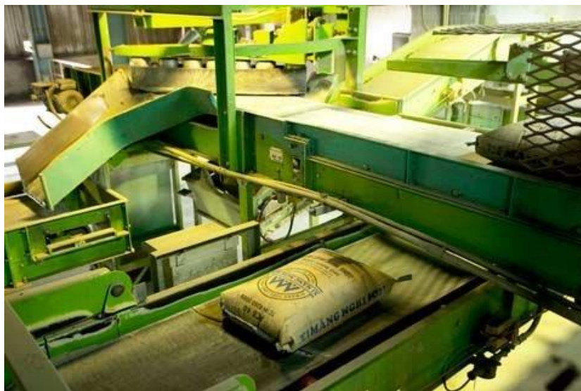
Hình 1.10: Băng tải trong nhà máy xi măng
