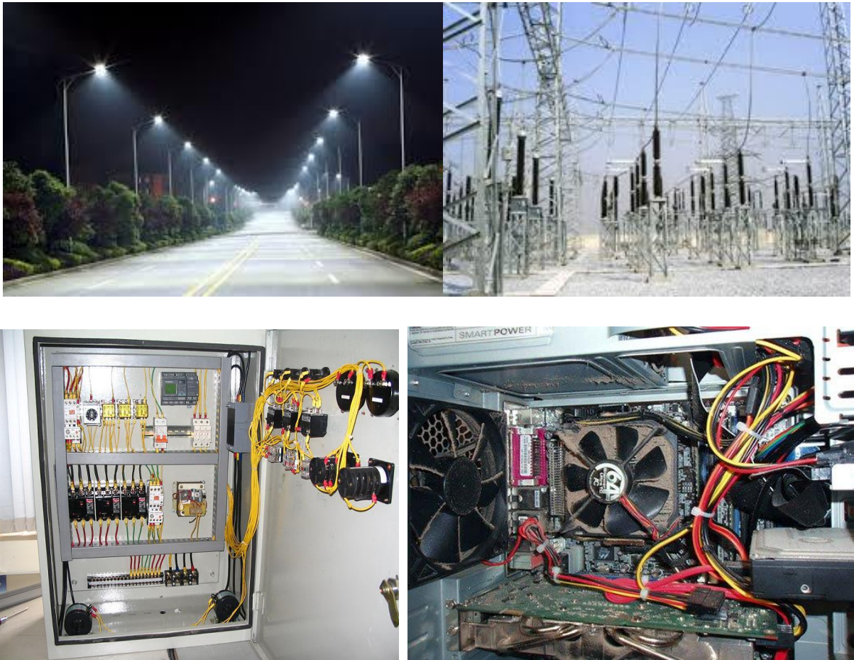
Hình 3.2 : Một số hình ảnh của dây cáp điện trong hệ thống điện
