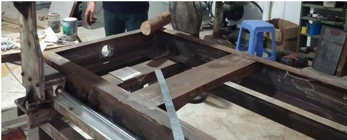
Hình 3.4: Lắp đặt sóng trượt 2
