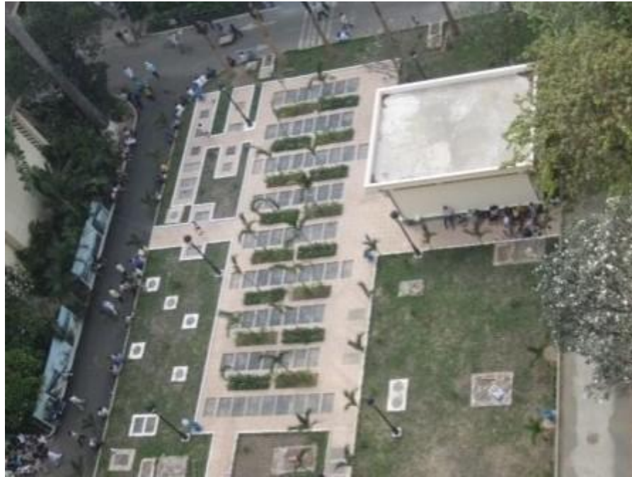
Hình 1.3. Trạm xử lý nước thải của bệnh viện Chợ Rẫy
