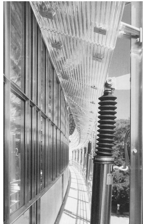
Die computergesteuerten Acrylglasprismen sind einachsig drehbar und werden dem Sonnenhöhenwinkel elektronisch nachgeführt. Die Metallfassade wurde im oberen Drittel mit einem Umlenkprisma im Scheibenzwischenraum der Isolierverglasung realisiert. Sie lenkt das diffuse Tageslicht gerichtet und blendungsfrei an die raumseitige Aluminiumdecke.
