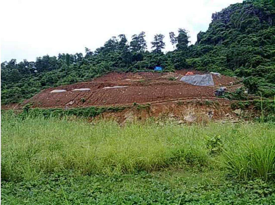
Nền móng chùa Long Hoa đang xây dựng
