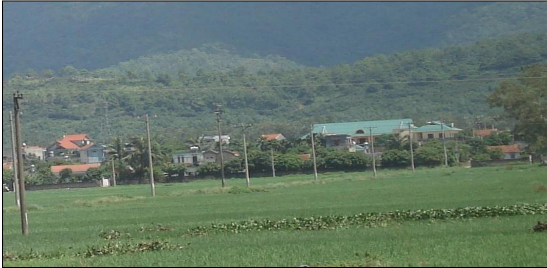
Hình 11 : Tuyến điện nổi 6KV
