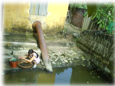
Hình 5: trạm bơm nước.
