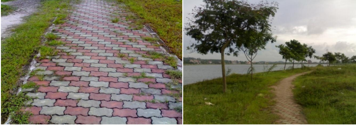
Đường dạo lát gạch bloc tự chèn
