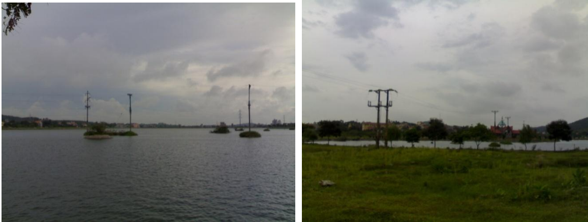
Tuyến đường điện 35KV chạy qua hồ.
