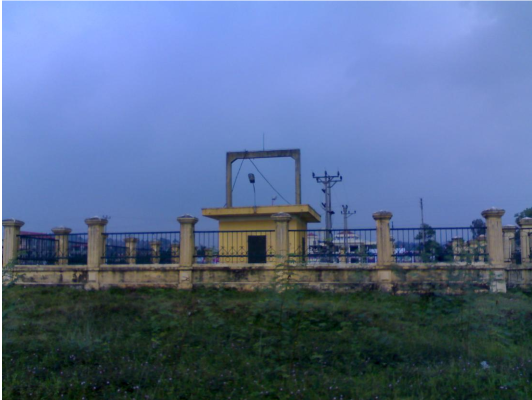
Trạm giếng khoan nước ngầm.
