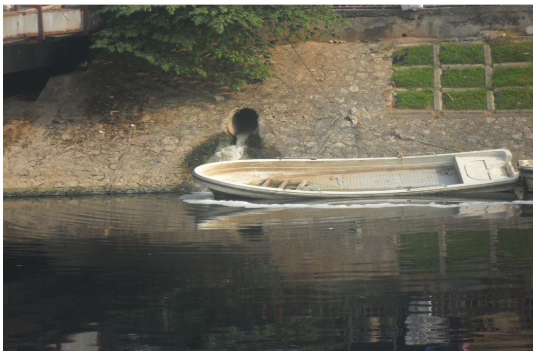
Ảnh: Cầu Định Công.
