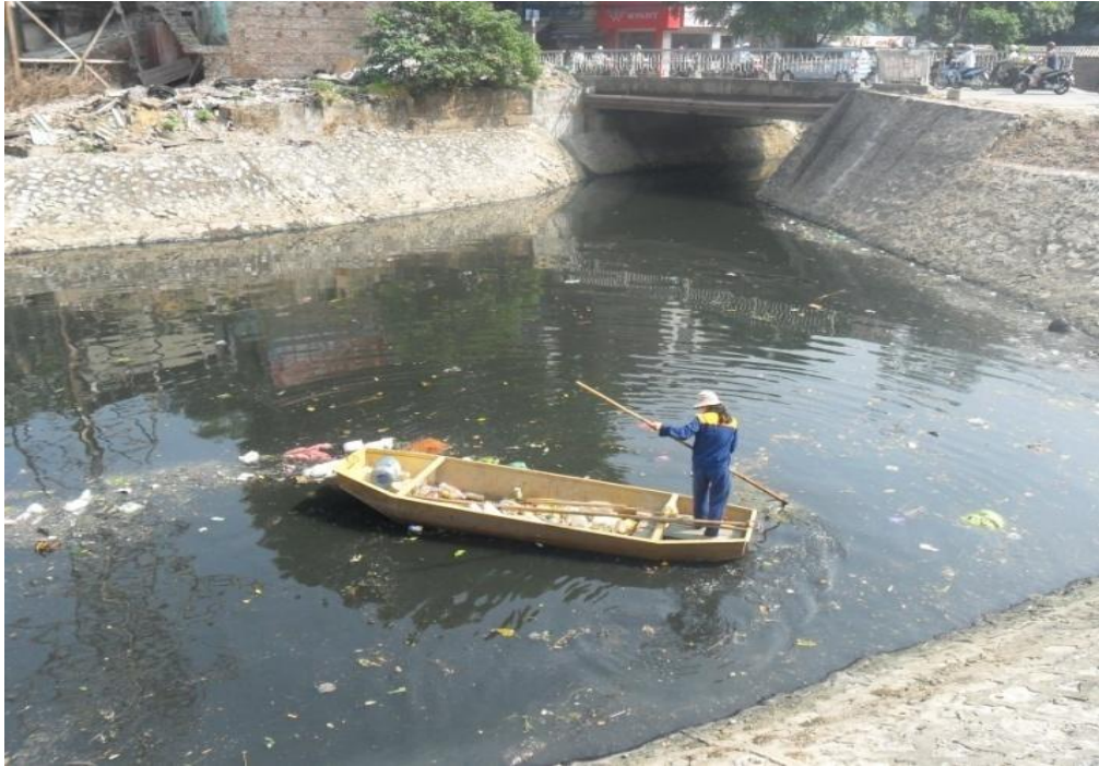
Ảnh: Nước và rác tại vị trí cầu Sét.
