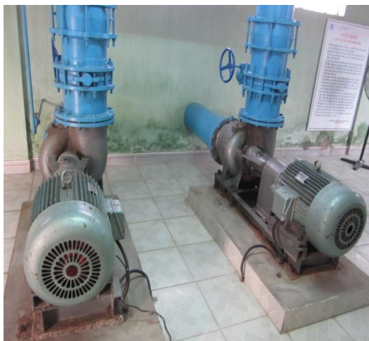
Hình E: Máy bơm rửa nước P4+P5
