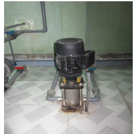
Hình B: Máy bơm vôi
