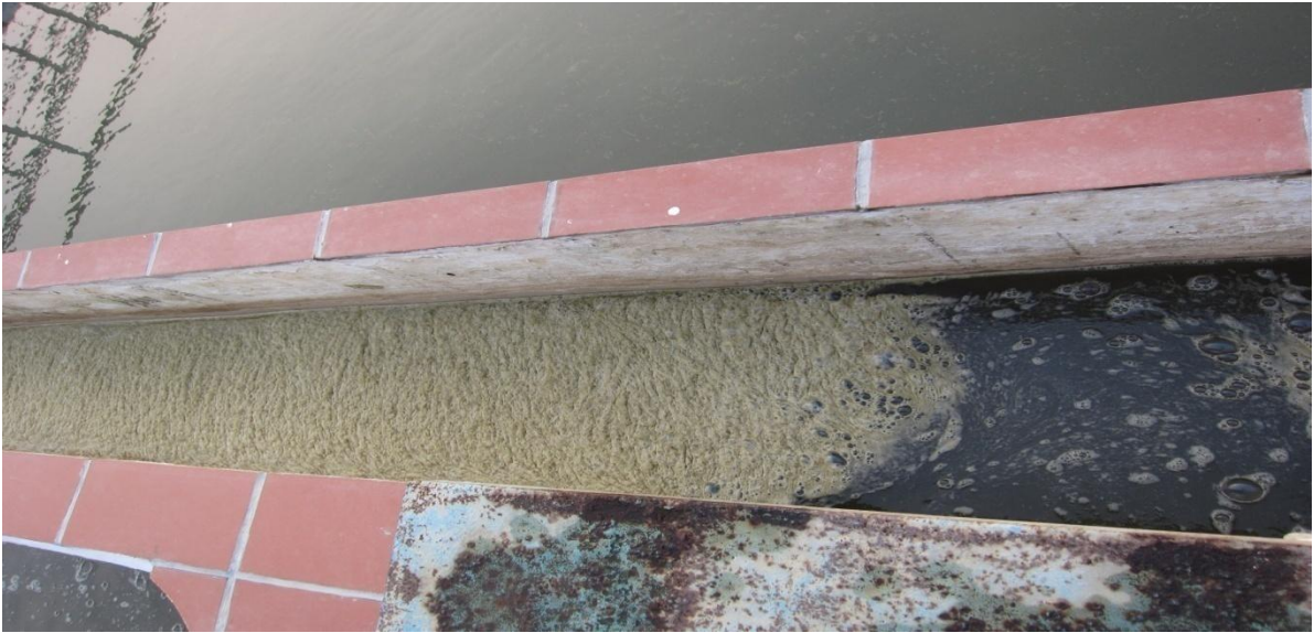
Hình 3.6: Mương dẫn nước từ bể phản ứng sang bể lắng
