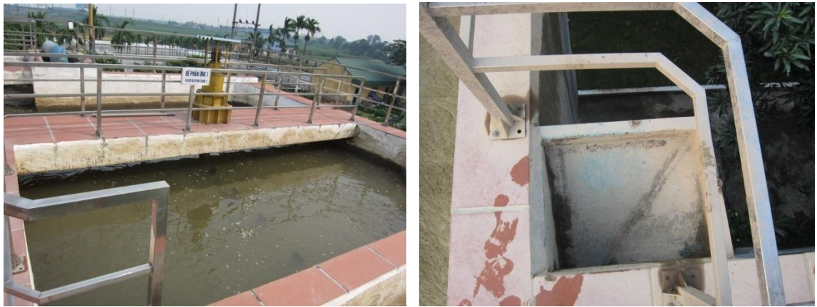
Hình 3.5: Bể phản ứng tạo bông cặn và máng thu bọt
