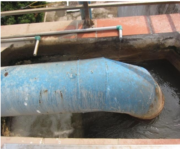
Hình 3.4: Bể trộn hóa chất
