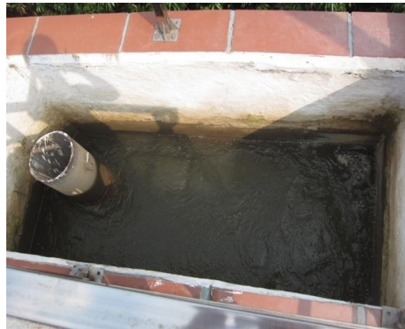
Hình 3.4: Bể trộn hóa chất
