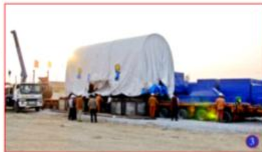
Hình 1, 2, 3: Xếp dỡ, vận chuyển Stator nặng 270Tấn cho Dự án Nhà máy nhiệt điện Hải Phòng.
