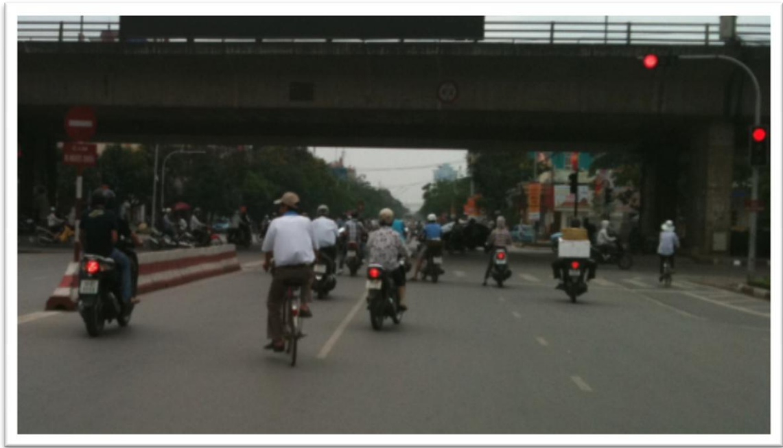
Hình 1.3: Nút giao thông cầu vượt Lạch Tray
