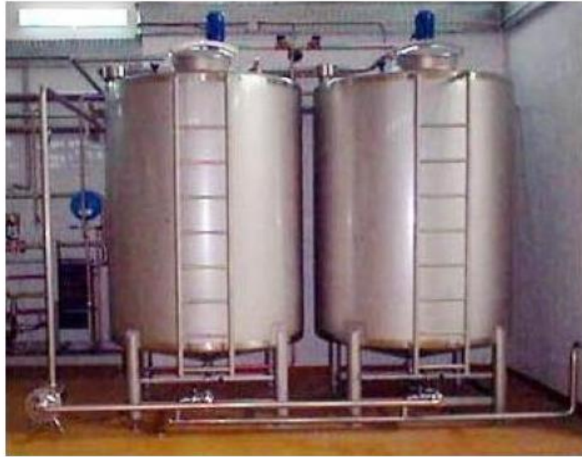
Hình 1.1: Bồn chứa – hệ thống pha trộn CIP
