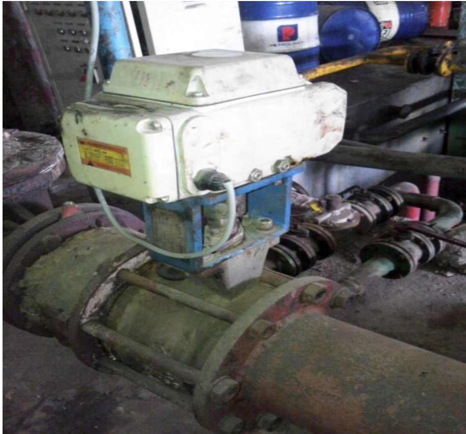
Hình 3.21. Van điện động dùng cho công nghiệp
