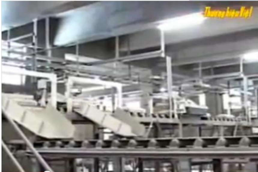
Hình 1.10: Băng tải trong nhà máy xi măng
