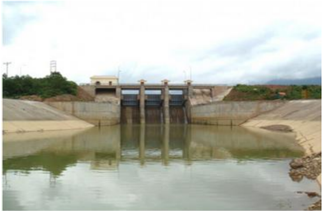
Hình1.3: nhìn từ hạ lưu tràn xả lũ
