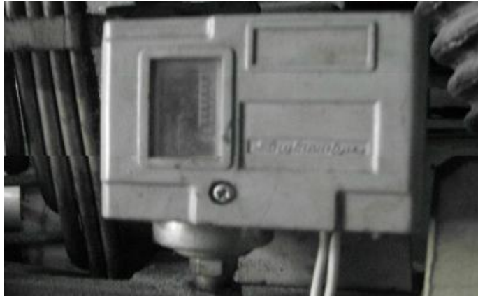
Hình 3.18: Role áp suất thấp
