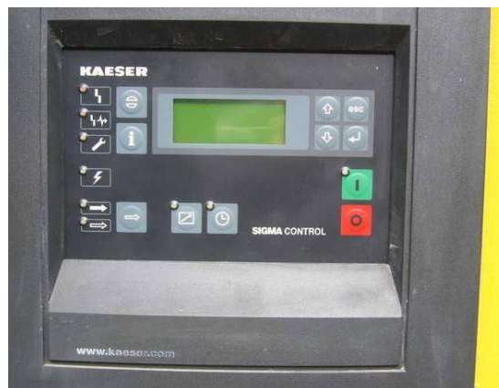
Hình 3.16: Màn hình hiển thị trên máy nén khí Kaeser- CHLB Đức
