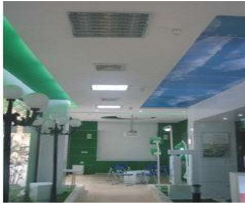
Hình 1.8. Tắt bật điện tự động ở hành lang
