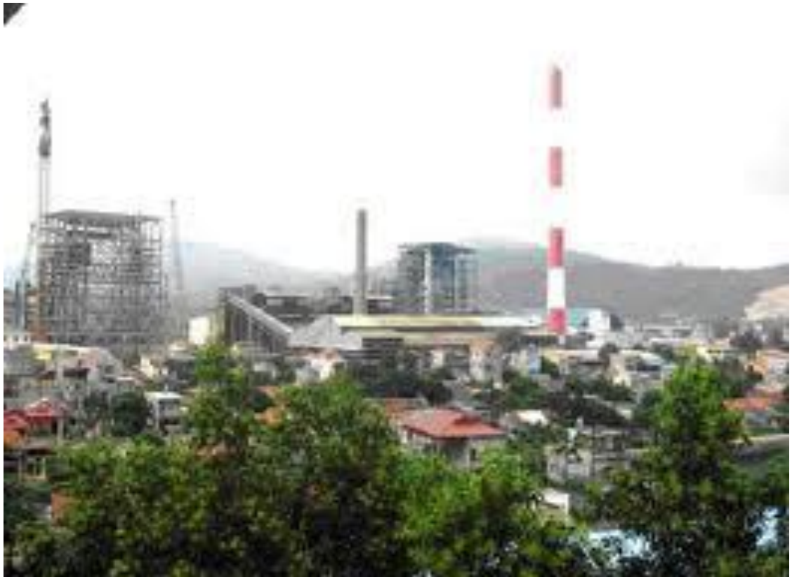
Hình 1.1: Toàn cảnh nhà máy nhiệt điện Uông Bí.
