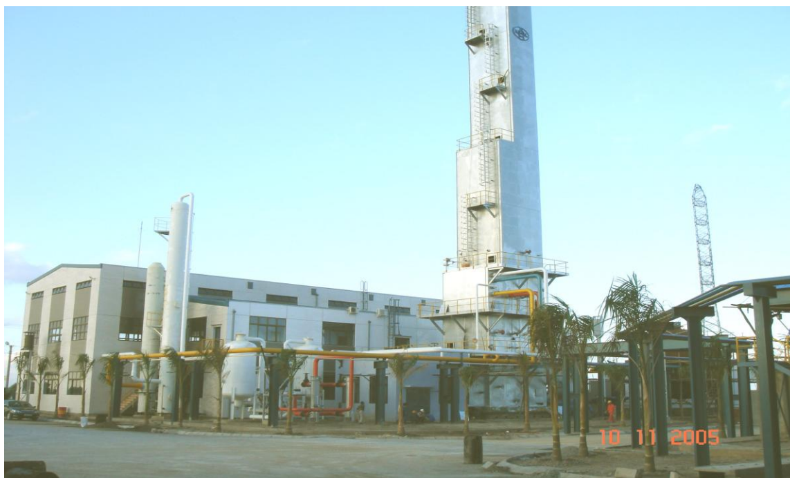
Hình 1.2. Nhà máy sản xuất khí công nghiệp.
