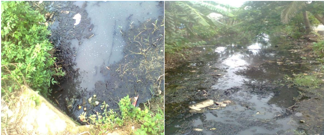
Hình 3.1: Hình ảnh hiện trạng kênh thoát nước chung
