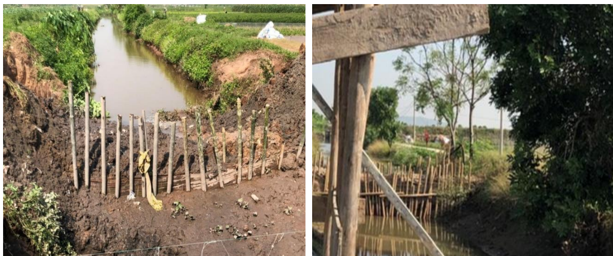
Hình 2.6. Hiện trạng công trình trên kênh
