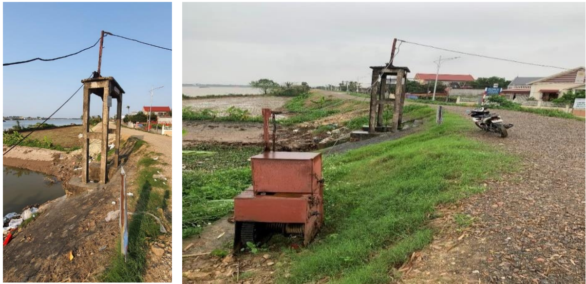
Hình 2.11. Hiện trạng giàn van, máy đóng mở cống Tiên Cựu
