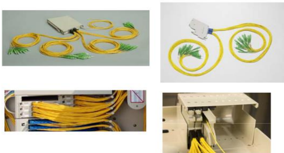
Hình 10. Splitter và vị trí trong FDH
