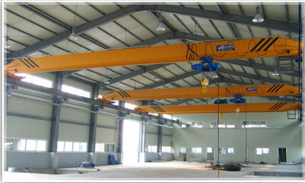
Hình 1.3 Cầu trục 1 dầm dẫn động bằng tay
