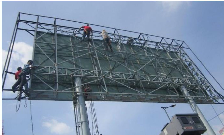
Hình ảnh 3: Thi công lắp đặt biển quảng cáo pano tầm lớn ngoài trời
