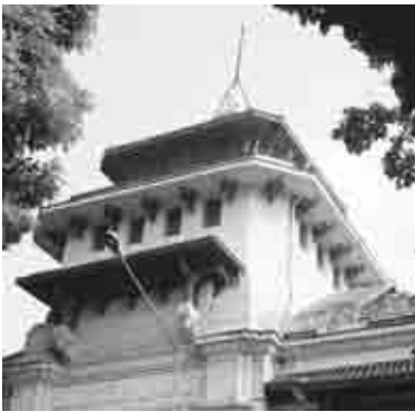
Hình 22.6 Cột chống sét.
